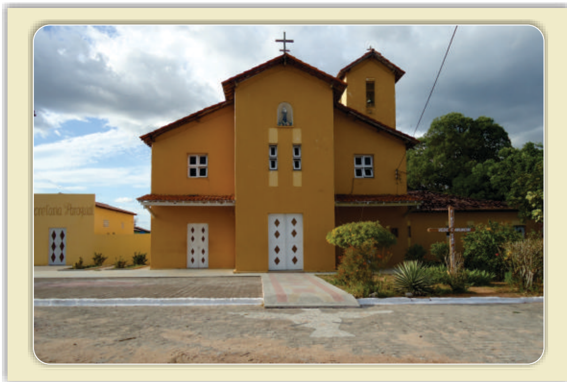
Convento de Santo Antônio no município de Glória
