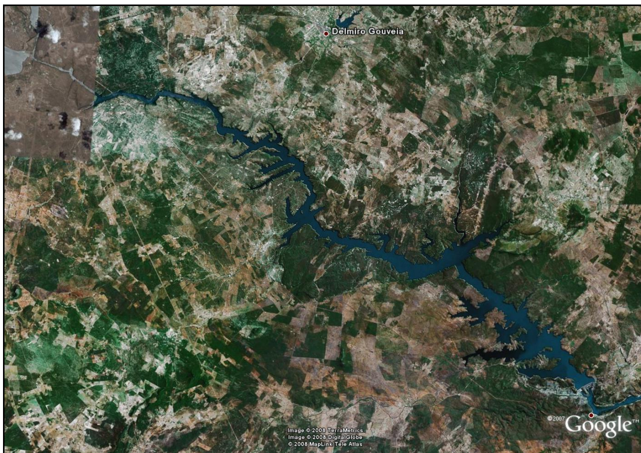
Figura 1 - Imagem do reservatório de Xingó (Fonte: Google Earth).
