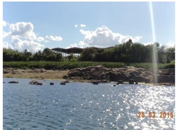
Foto 36: Visão geral do ponto Galpão
