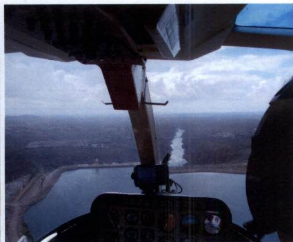
Foto 4 - Vista aérea do final do reservatório de Paulo Afonso. Ao fundo o início do reservatório de Xingó
