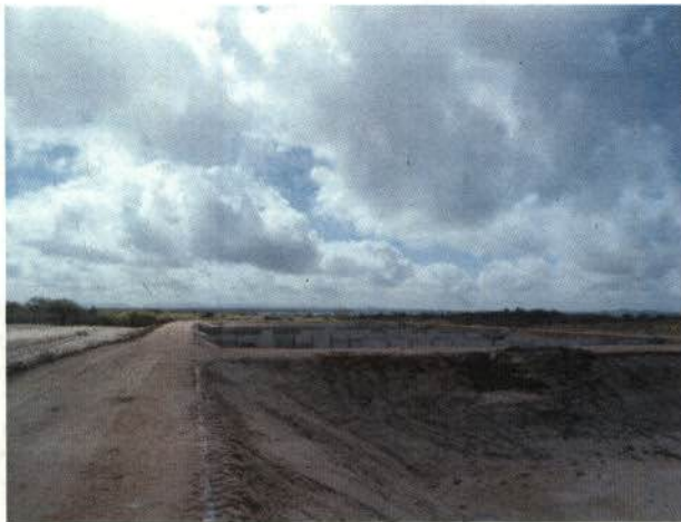
Foto 19: Obra da futura Estação de Tratamento de Esgoto - ETE, Glória/BA.
