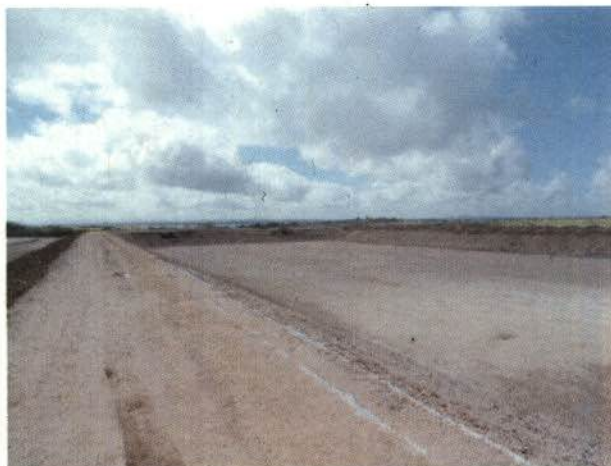
Foto 16: Obra da futura Estação de Tratamento de Esgoto - ETE, Glória/BA.
