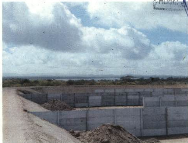
Foto 20: Estrutura de Tratamento Secundário. Glória/BA
