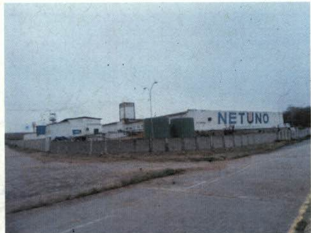
Foto 10: Entrepósito pesqueiro da Netuno vizinho ao Complexo Hidrelétrico Paulo Afonso.
