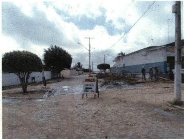
Foto 13: Obras de saneamento básico em Glória/BA
