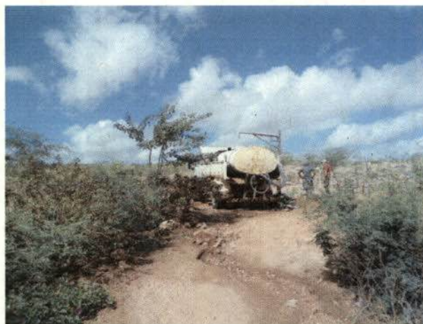
Foto 23: Captação de água por caminhões pipa. Distrito de Quixaba/BA
