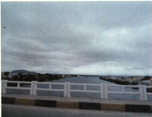
Foto 3: Vista do Reservatório no município de Paulo Afonso/BA
