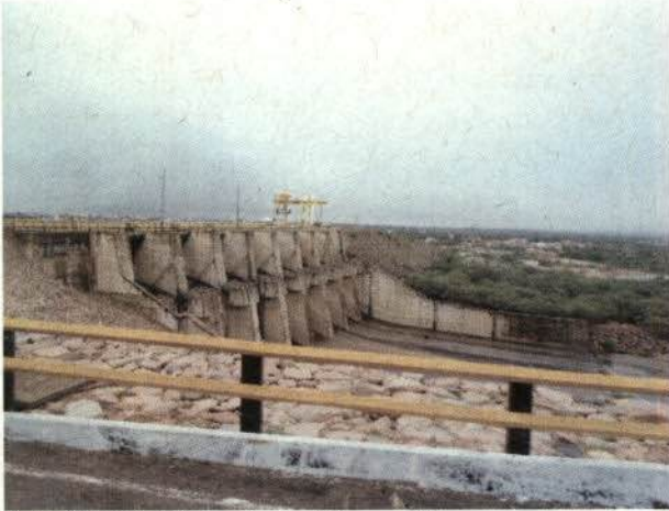
Foto 7: Hidrelétrica Paulo Afonso IV
