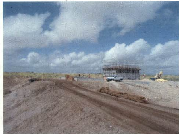
Foto 17: Obra da futura Estação de Tratamento de Esgoto - ETE, Glória/BA.
