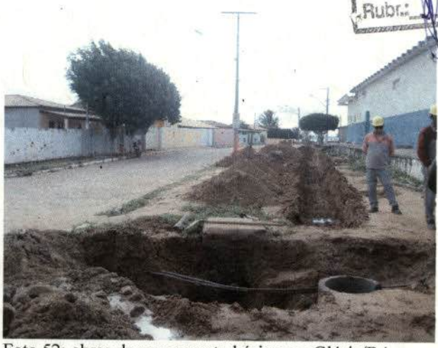
Foto 52: obras de saneamento básico em Glória/BA.
