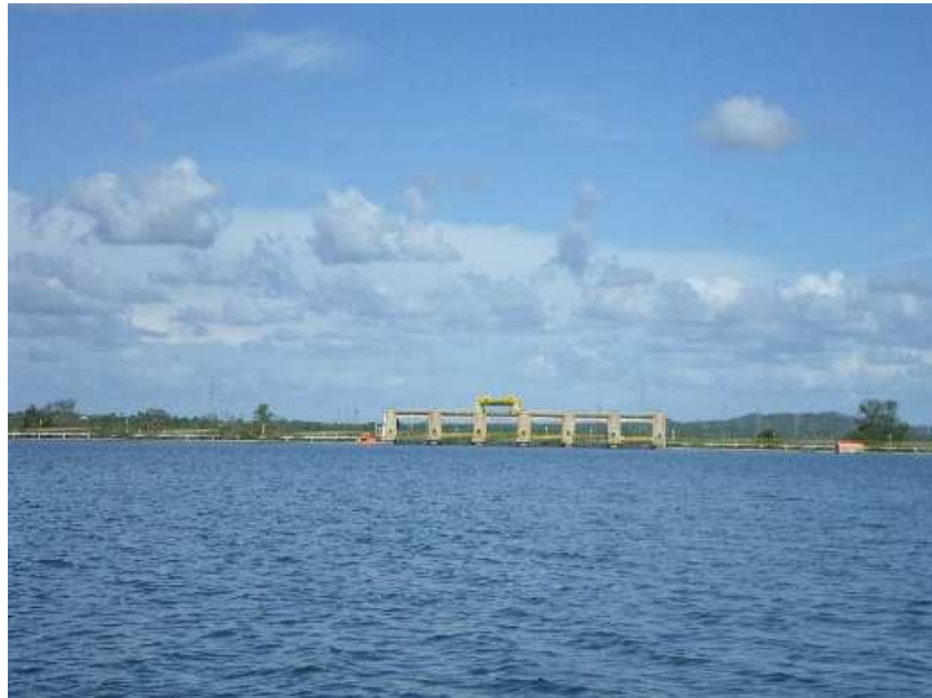
Fig. 4.6.2.1 – vista do reservatório
