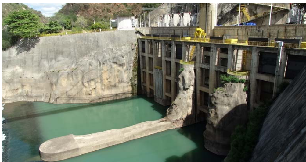
Usina PA III e I
