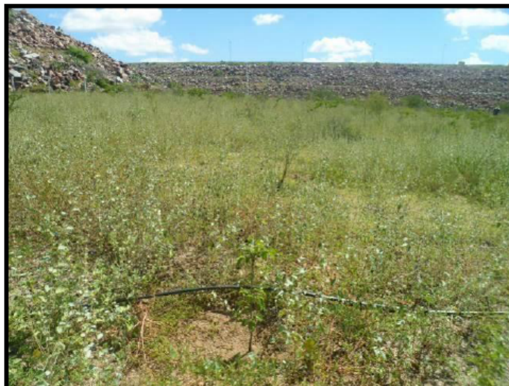
Instalação de sistema de irrigação por gotejamento.
