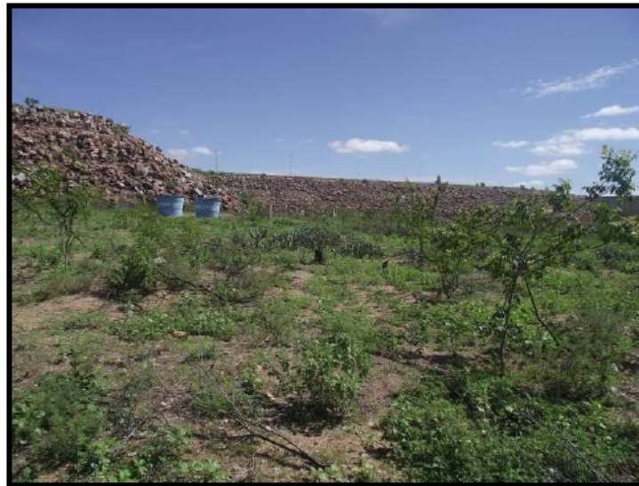
Instalação de reservatórios de água para irrigação.
