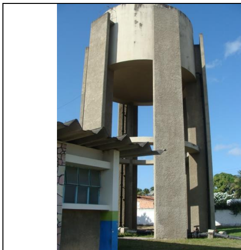
Figura 1 – Instalações da Casal em Piaçabuçu/AL. Coordenada geográfica: 10°24'19,5"S/ 36°25'47,4"W.
