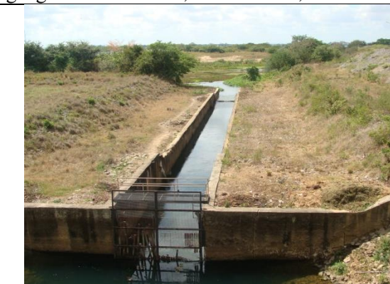
Figura 4 – Canal de captação d'água da Deso em Propriá/SE. Coordenada geográfica: 10°11'24,1"S/ 36°50'59,9"W.
