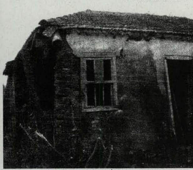
Foto 16 - Parte destruída, vista externa
