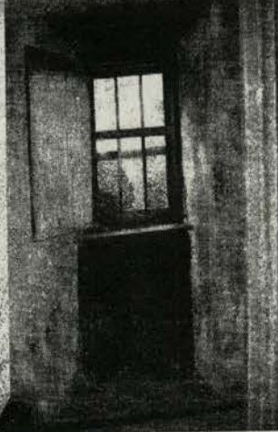
Foto 4 - Detalhe da janela em interior de cômodo
