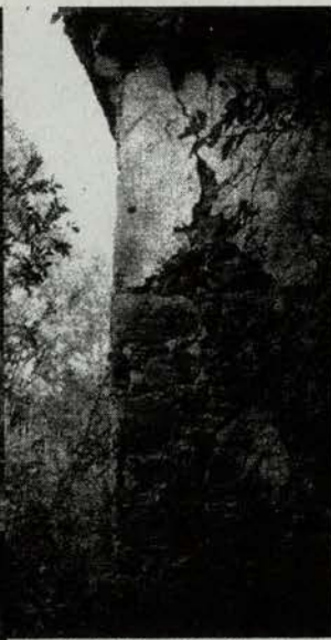
Foto 10 - Detalhe da parede exterior
