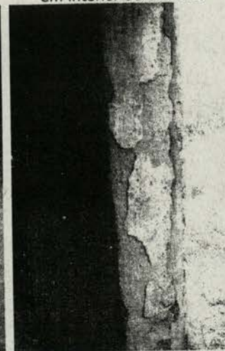
Foto 7 - Detalhe da espessura da parede
