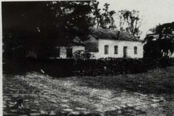
Foto-1- Vista do conjunto em 2001
