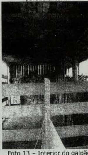
Foto 13 - Interior do galpão
