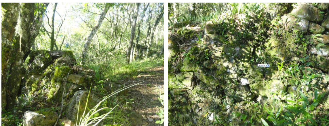
Figura 11 e 12: As duas entradas do sítio estão alinhadas, de um lado chega-se ao rio Pelotas e do outro se chega ao rio dos Touros. De uma entrada a outra entre as áreas de ruínas tem 27 metros de largura. A
