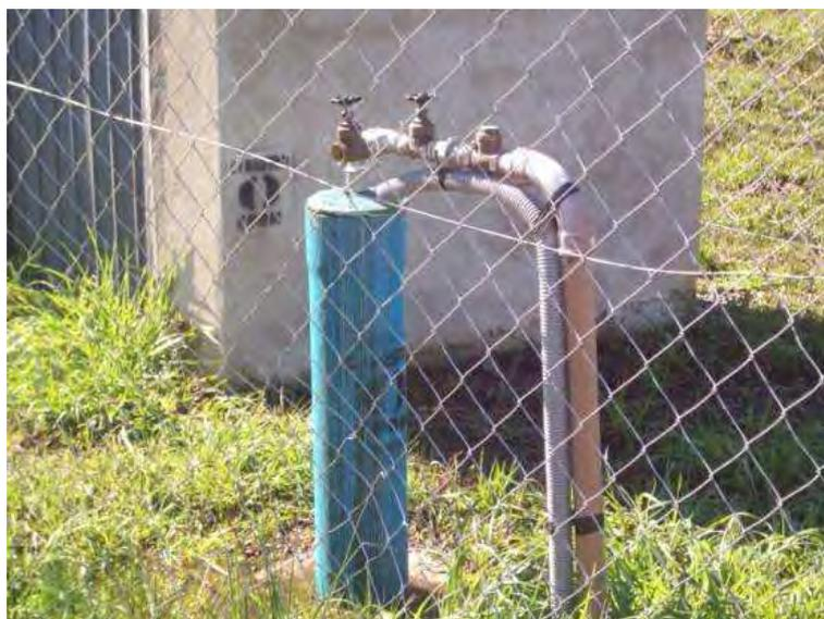
Ilustração 6-206. Poço tubular para captação da água subterrânea (SIAGAS 4300018847) localizado na AII, em Capão Alto/SC (Coordenadas: 547.515 mE e 6.904.526 mN). Notar na ausência de tubo guia na “boca” do poço.
