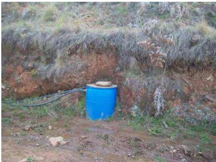
**Ilustração 6-204. Poço localizado na AID, em Lages/SC, estrada para Arroio Cará, localidade de Coxilha Rica (Coordenadas: 552.661 mE e 6.867.123mN). Captação de água por nascente canalizada com uso de mangueiras de PVC. Cota potenciométrica 1.032 m.**
