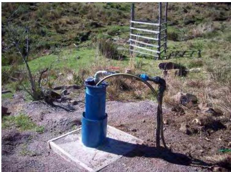
**Ilustração 6-205. Poço tubular para captação de água subterrânea localizado na AII, em Bom Jesus/RS (Coordenadas 561.749 mE e 6.839.068 mN). Notar na “boca” do poço a inexistência de tubo guia em PVC plástico para medição de nível de água com freatímetro.**
