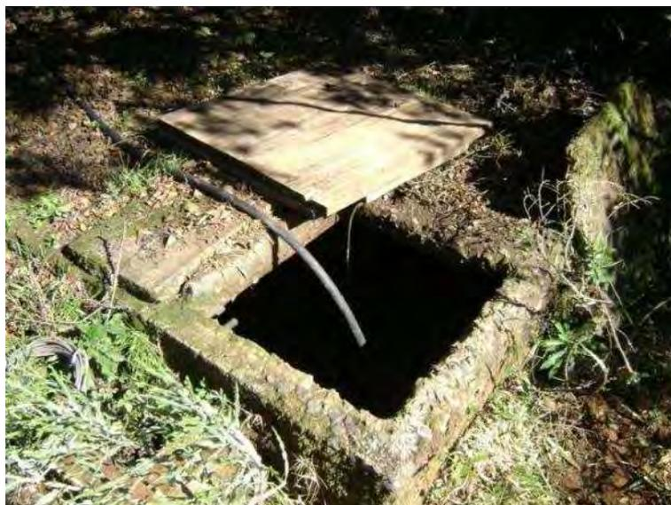
**Ilustração 6-203. Poço localizado na AII, em Bom Jesus/RS, na Fazenda Três Marias (Coordenadas: 535.049 mE e 6.852.708 mN). Captação de água por nascente canalizada, com reservatório em concreto. Cota potenciométrica de 982 m e nível estático da água de 1,27 m.**
