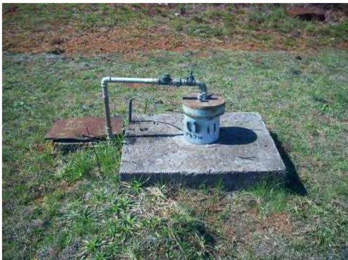
**Ilustração 6-210. Poço tubular para captação de água subterrânea (SIAGAS 4300012182), localizado na AII, em Vacaria/RS, praça de pedágio da BR 116 km 22 (Coordenadas: 515.345 mE e 6.860.158 mN). Notar a existência de tubo guia na “boca” do poço. Cota altimétrica 940 m.**
