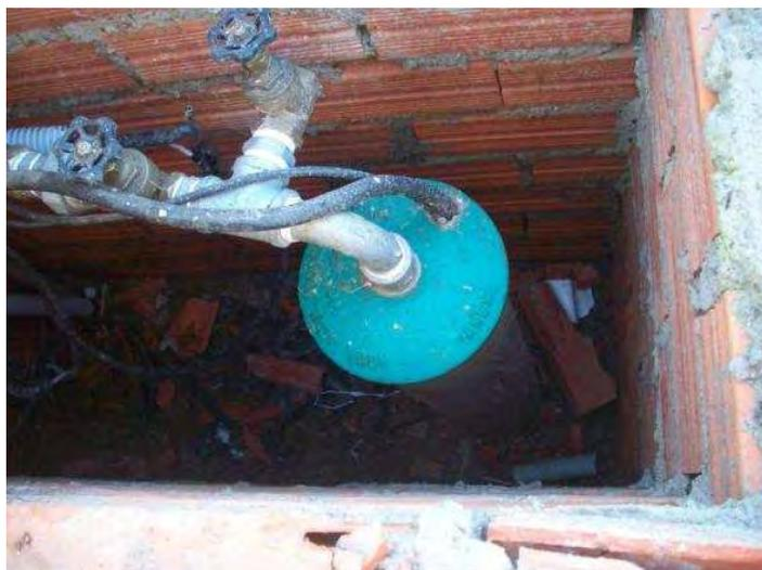
**Ilustração 6-208.** Poço tubular para captação de água subterrânea (SIAGAS 4300018845) localizado na AII, em Capão Alto/SC, localidade Vacas Gordas (Coordenadas: 544.722 mE e 6.902.028 mN). Notar na “boca” do poço a inexistência de tubo guia para medição do nível da água e ausência de torneira para captação de água.
