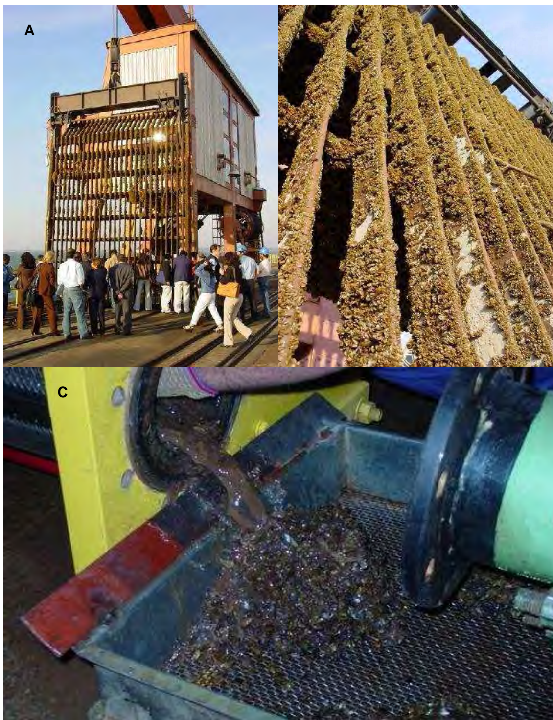
Ilustração 6-629. Impactos do mexilhão dourado sobre hidrelétricas.
