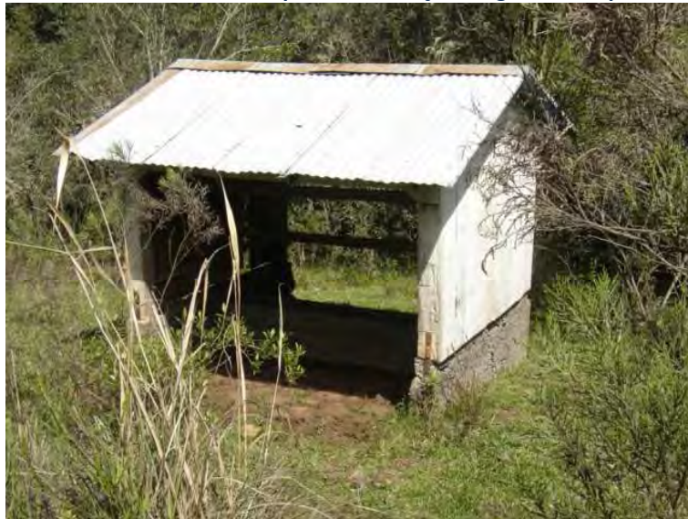
Ilustração 6-913. Apoio para o gado beber água, construído em alvenaria com telha de fibrocimento.
