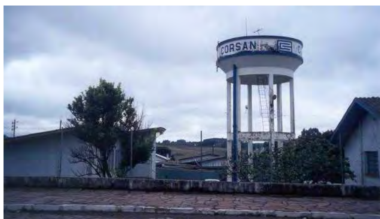
Ilustração 6-844. ETA captação - Arroio do Estaqueador.
