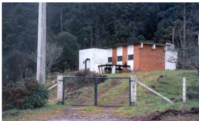
Ilustração 6-858. ETA – Captação rio Antonina.
