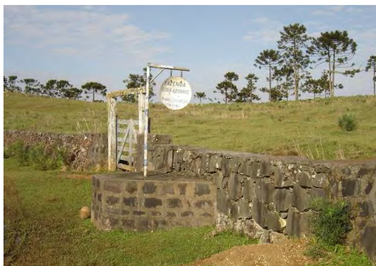
Ilustração 6-902. Entrada da Fazenda Sobradinho. Coordenadas: E 0548923; N 6862245.
