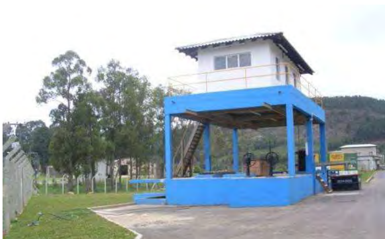
Ilustração 6-854. Estação Elevatória de Lages/SC.
