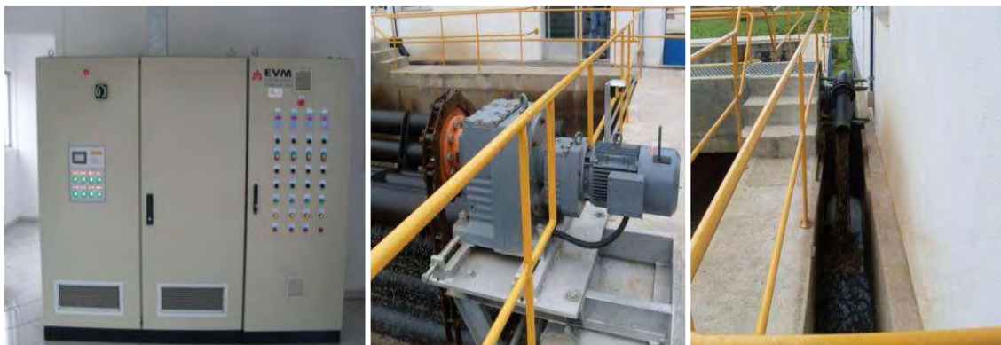
Ilustração 6-855. Sistema de controle do módulo 1 totalmente informatizado, motor de um dos aeross, sistema de retroalimentação.
