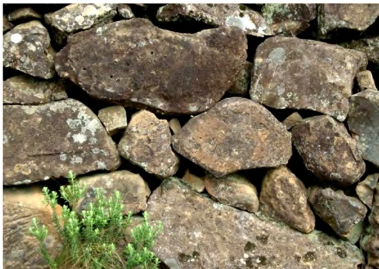
Ilustração 6-898. Detalhe de muro de taipa; pode-se observar a disposição dos diferentes tamanhos das pedras no encaixe.
