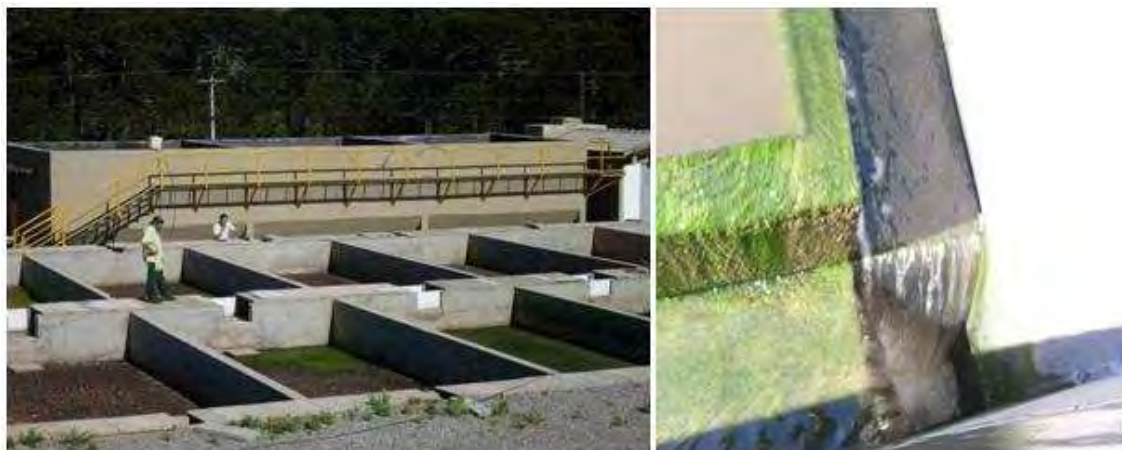
Ilustração 6-862. Leito de Secagem de Lodo sendo inspecionado por funcionários, Elevatória de Retorno de Lodo ao fundo e saída do esgoto tratado.
