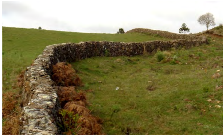
Ilustração 6-895. Muro de taipa em profundidade, sentido longitudinal.
