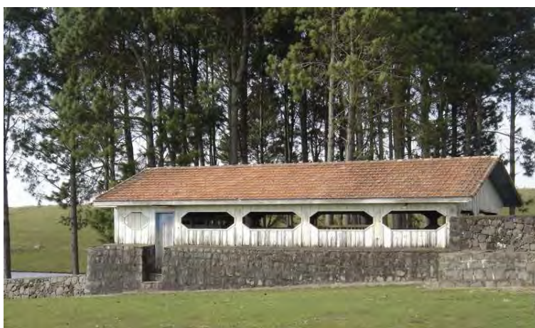
Ilustração 6-904. Estábulo para acomodar o gado, construído em madeira e telha de barro.
