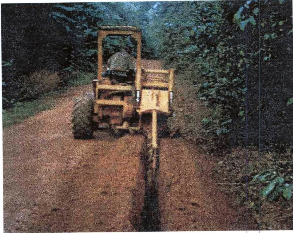
Escavação da trincheira.
