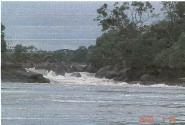
Fig. 3 – Local próximo à jusante do futuro canal da PCH Salto Cafesoca.
