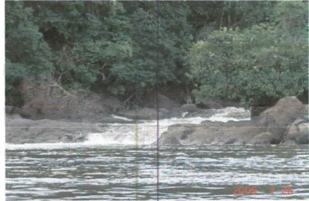
Fig. 4 – Jusante do futuro canal. Vista aproximada.
