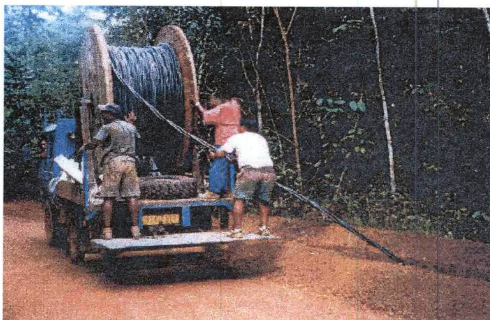
Lançamento dos cabos na trincheira.
