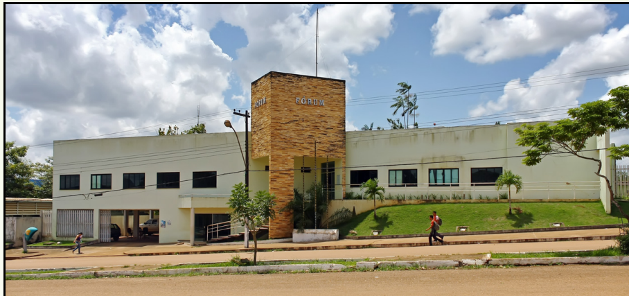
Foto 22 - Localizado na área central, o Fórum da Comarca de Oiapoque é constituído por duas varas e um juizado que atende todo o município.
