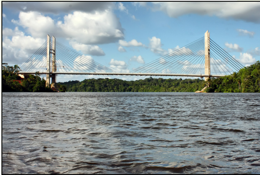
Foto 10 - Vista da Ponte recentemente construída e que servirá de ligação entre o Brasil e a Guiana Francesa. No acordo assinado, ambos os países se comprometem a pavimentar suas estradas de rodagem até as capitais de Macapá e Caiyene, de forma a facilitar a ligação entre as nações e o desenvolvimento turístico.
