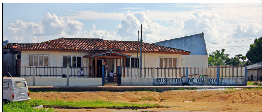
Foto 21 – Vista frontal do Centro de Custódia do município de Oiapoque, unidade pública estadual que passa neste ano de 2011 por uma reforma de suas instalações.
