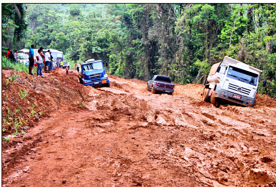
Foto 26 - Muito precária, a ligação dos municípios de Oiapoque aos demais, incluindo a capital Macapá, é extremamente deficiente no período chuvoso, ficando mesmo intransponível o tráfego na BR – 152, isto em função do trecho não pavimentado e com grandes áreas de atoleiros.
