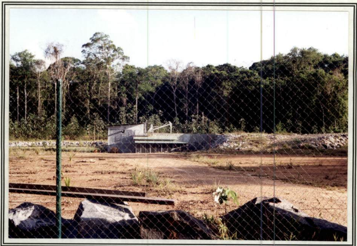
Foto 10 - Margem francesa - Usina da PCH Sault Maripá.
