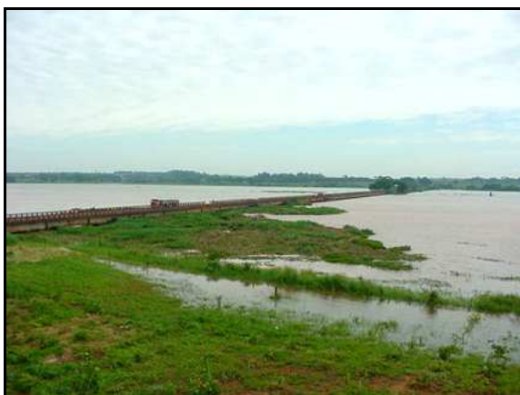
Foto 25 – Vista do aporte de macrófitas na ponte sobre o rio Grande, após a confluência com o rio Pardo (FONTE: FURNAS).
