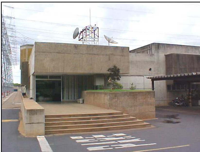
Foto 7 – Vista da casa de força – entrada principal (FONTE: MRS).
