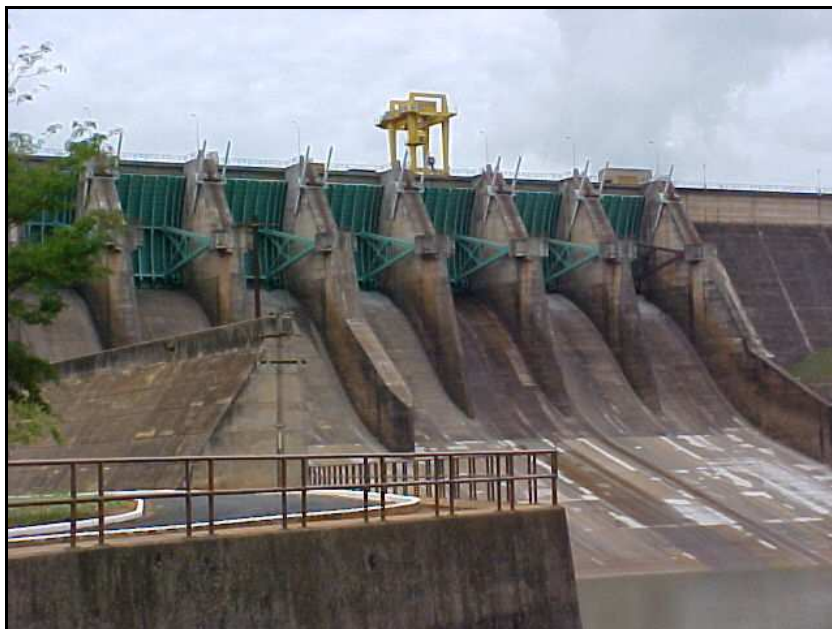
Foto 5 – Vista dos vertedouros da usina de Marimbondo (FONTE: MRS).
