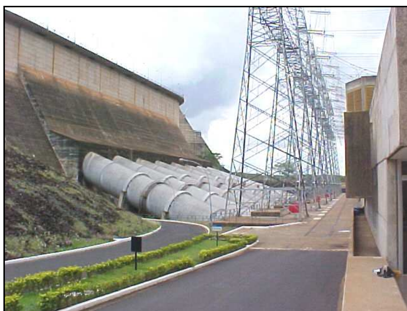
Foto 6 – Vista dos condutos forçados (FONTE: MRS).
