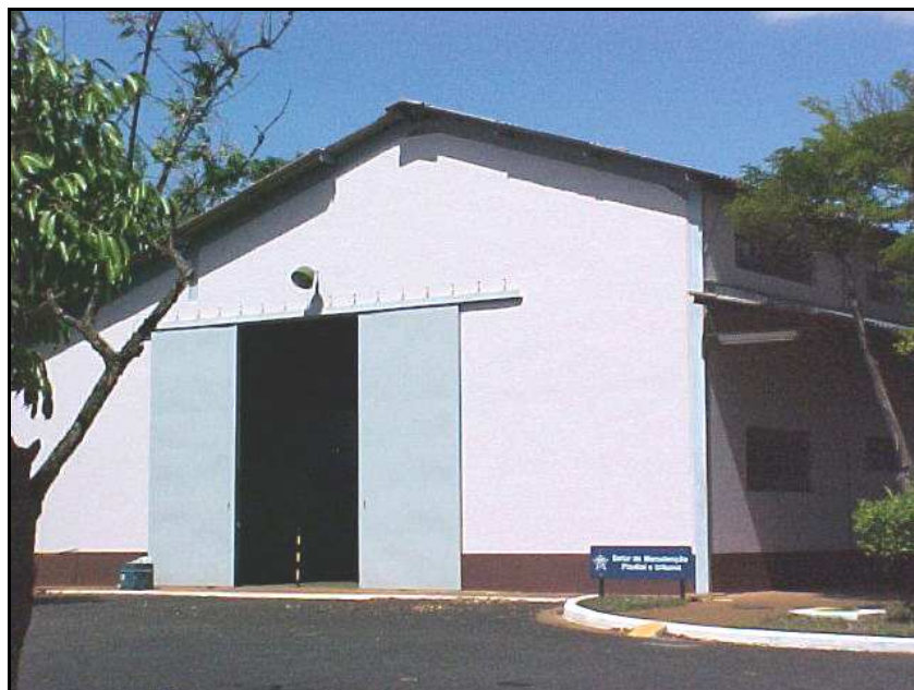
Foto 19 – Vista da Manutenção Predial da UHE Marimondo (FONTE: MRS).
