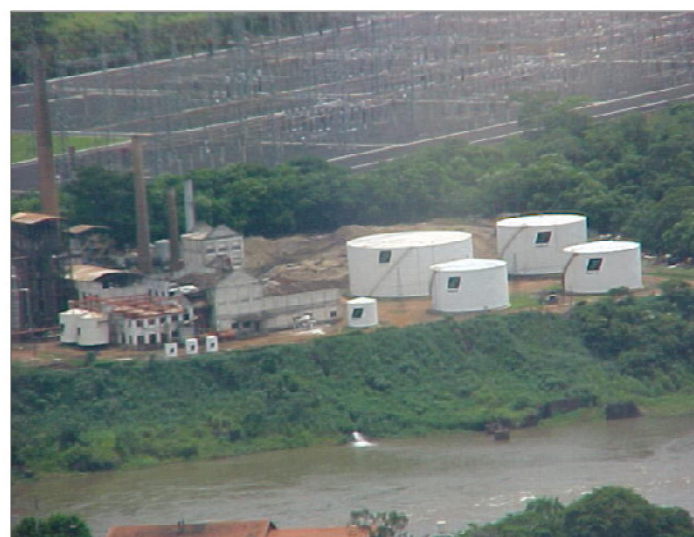
Foto 29 - Usina de álcool a jusante da UHE
