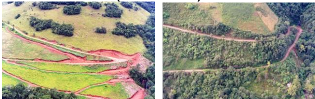
FOTO 3 – ACESSO À BALSA NOVA GAÚCHA (RS) E A DE CELSO RAMOS (RIO CANOAS)
