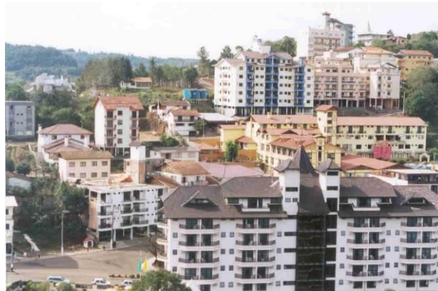
FOTO 113 - TERMASA – PISCINAS E O NOVO HOTEL
