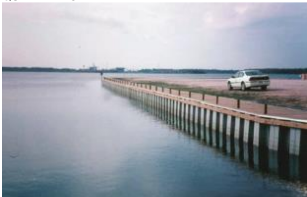
FIGURA 51: EXEMPLO DE CONTENÇÃO POR ESTAQUEAMENTO
