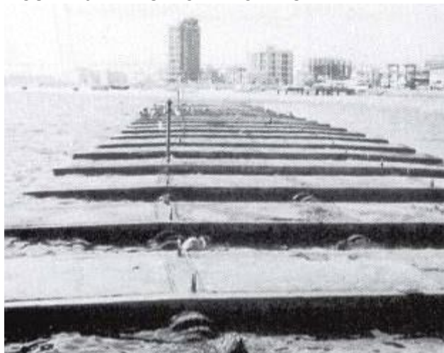
FIGURA 40: ATENUADOR DE ONDAS
