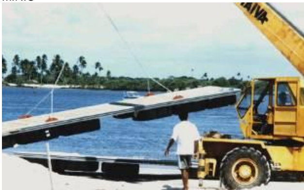
FIGURA 50: INSTALAÇÃO DE FLUTUANTES DE ALUMÍNIO
