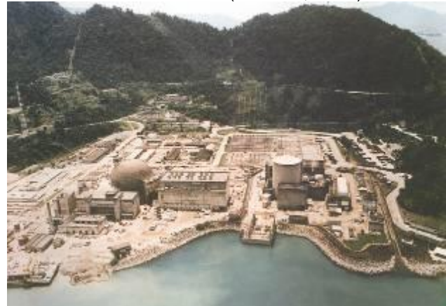
FOTO 4 – USINA NUCLEAR (ANGRA I, II E III)
