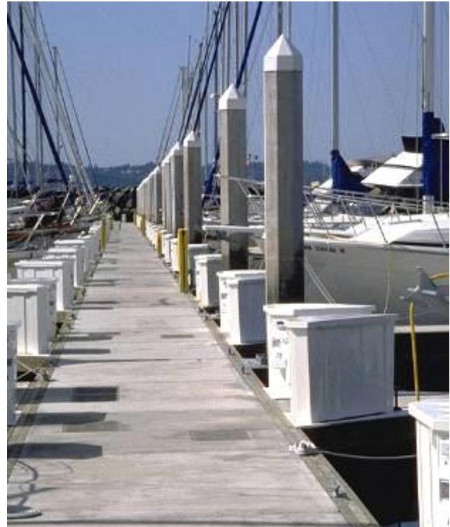
FIGURA 48: DOCAS FLUTUANTES DE CONCRETO
