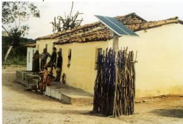
FOTO 7 – ENERGIA FOTOVOLTAICA / SOLAR (ESCOLA ISOLADA)
