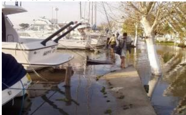
FIGURA 39: ESTRUTURAS MAL PLANEJADAS
