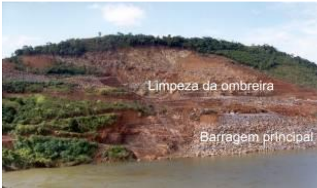
FOTO 23 – OBRAS DA BARRAGEM PRINCIPAL
