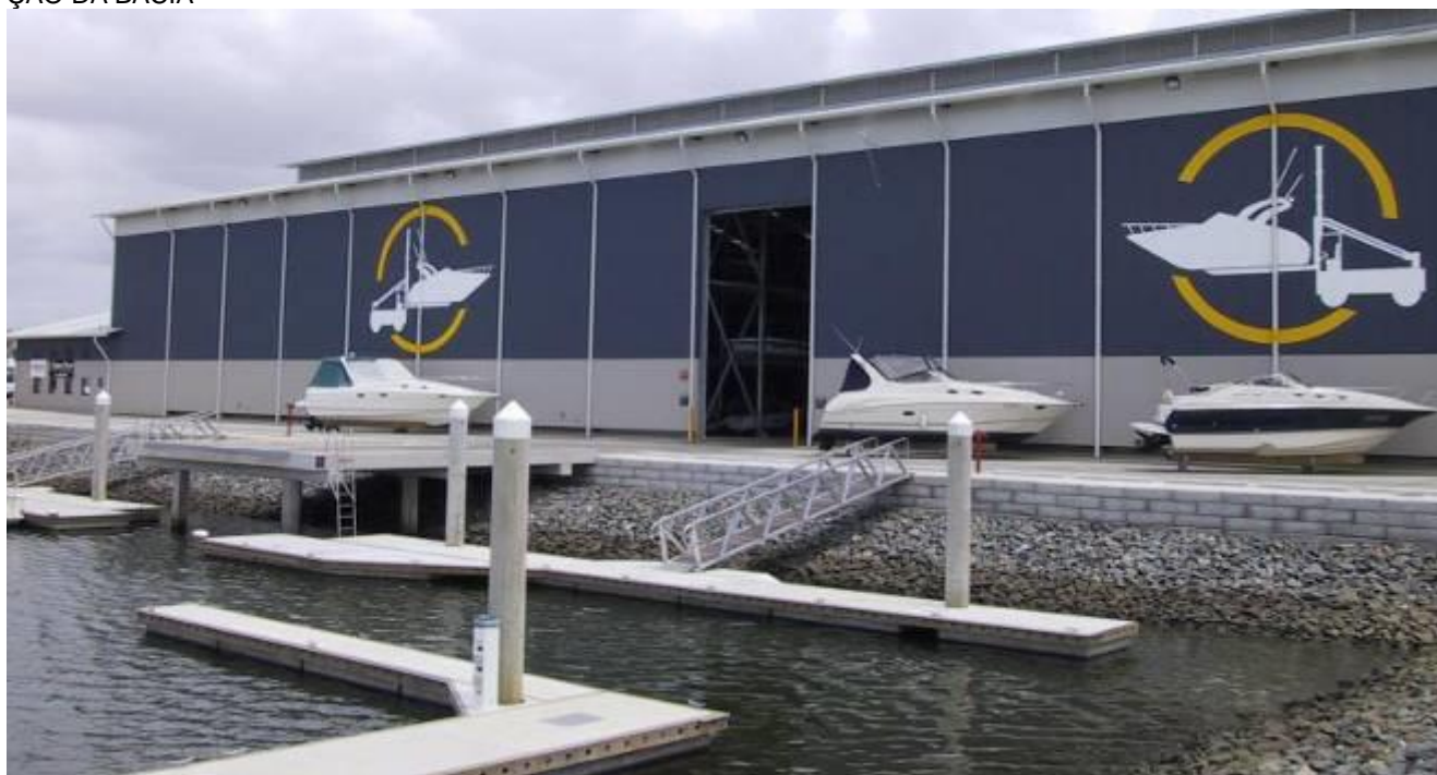
FIGURA 52: ESTRUTURAS E CONTENÇÕES: ESTRUTURA METÁLICA NO GALPÃO E “DRystack”; ESTACAS DE CONCRETO NAS DOCAS FLUTUANTES; TALUDE PROTEGIDO POR PEDRAS DE MÃO (RIP-RAP) NA CONTENÇÃO DA BACIA
