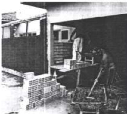
Trabalhadores já estão na fase final
