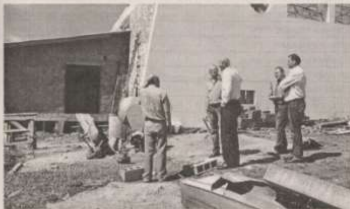
MAXIMILIANO DE ALMEIDA- OBRAS SÃO SEBASTIÃO
