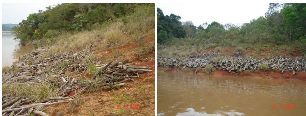
Figura 27: Imagens da área de restauração 19.
