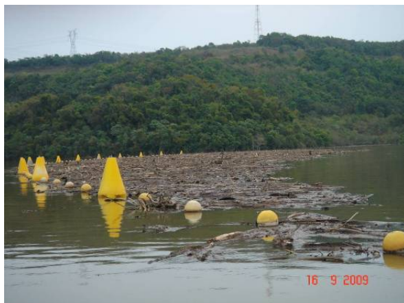
Figura 4: Troncos e galhos acumulados em barreira de contenção próxima ao barramento da UHMA.
