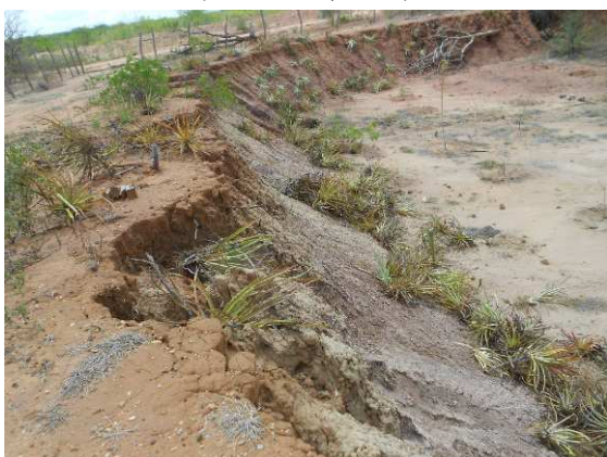
Img. 172 – Plantio de macambira nos barrancos da área 3 a fim de conter o processo erosivo. (Janeiro, 2015)
