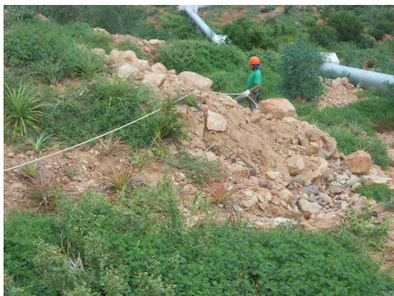
Img. 224 – Equipamentos para Rapel é utilizado no Talude (Maio de 2014)
