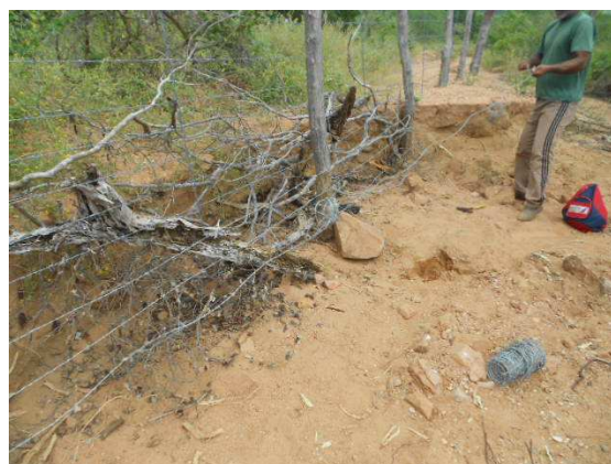
Img. 351 – Manutenção de cerca danificada pela erosão provocada pelas fortes chuvas. (Petcon 2014)
