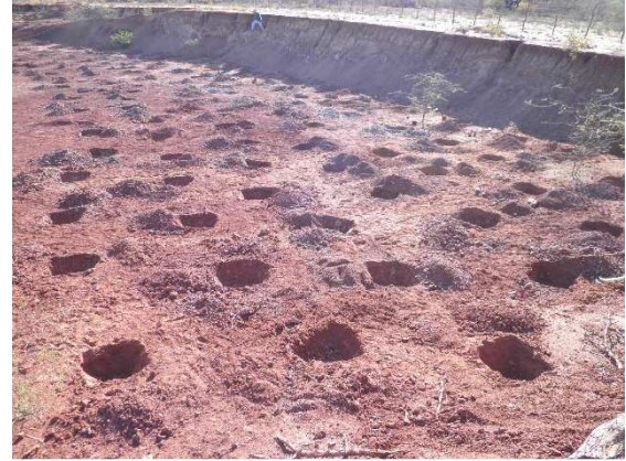
Img. 91 – Coveamento de acordo com as especificações técnicas da DEMG-10-R00-2010. (Julho, 2012).
