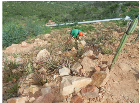
Img. 223 – Devido a inclinação o plantio no Talude exige a utilização de EPI's especiais (Maio de 2014)
