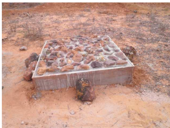
Img. 41 – Base para apoio do reservatório da área 3 finalizada. (Junho, 2012).
