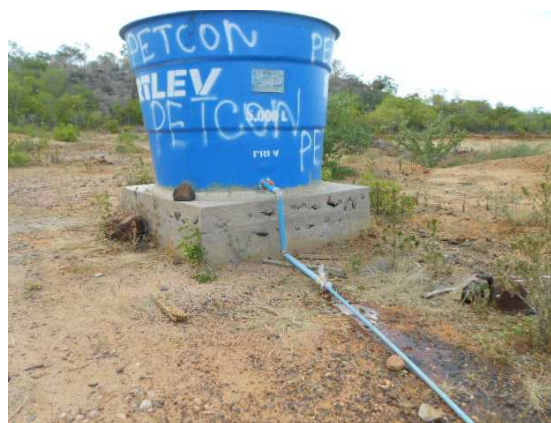
Img. 301 – Reservatório da área 4. (Petcon 2014)
