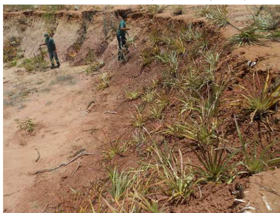
Img. 173 – Todo o barranco foi preenchido com macambira a fim de conter o aumento da erosão (Janeiro, 2015)
