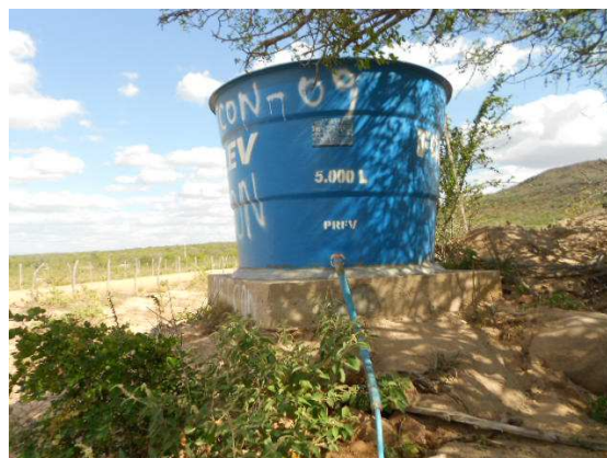
Img. 305 – Reservatório '1' da área 9. (Petcon 2014)
