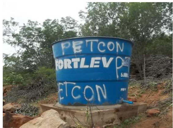
Img. 45 – Reservatório instalado na área 06 (Outubro, 2012)
