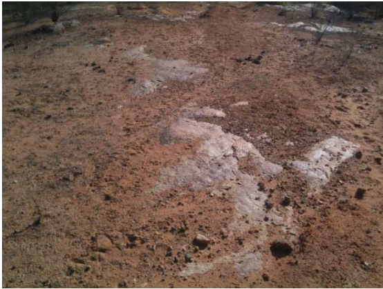
Img. 86 – Solo com rochas exposta na área da jusante.
