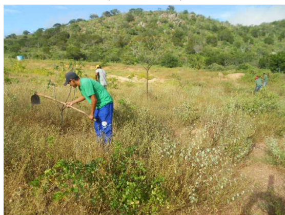
Img. 273 – Manutenção com capina e coroamento na área 6. (Petcon 2015)
