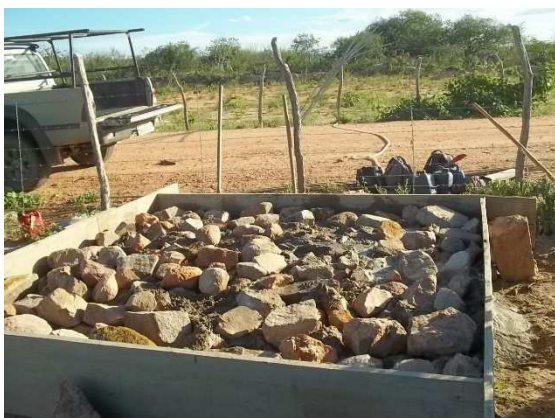
Img. 40 – Construção da base para apoio e nivelamento do reservatório na área 7. (Junho, 2012).
