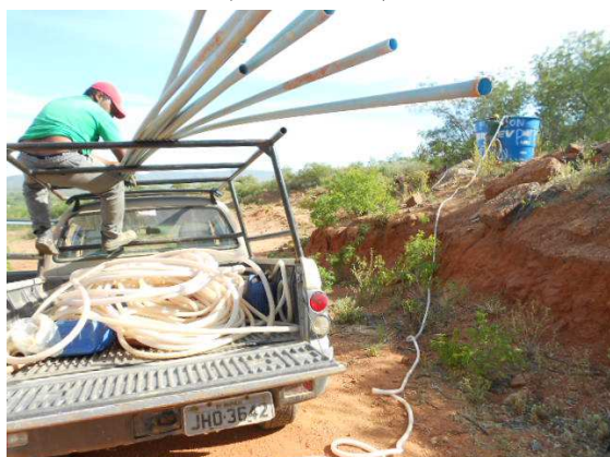
Img. 302 – Reservatório instalado na área 5. (Petcon 2014)
