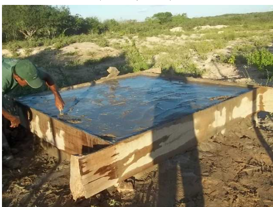
Img. 38 – Construção da base para apoio e nivelamento do reservatório na área 6. (Junho, 2012).
