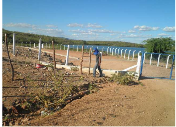
Img. 25 – Cercamento da área 10(Maio, 2012).
