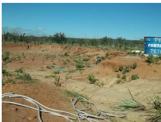
Img. 300 – Reservatório instalado na área 3. (Petcon 2014)
