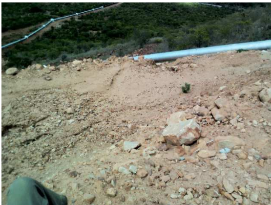
Img. 408 – Talude – área 8 (Petcon 2012)
