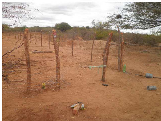
Img. 28 – Início do cercamento da área 3. (Maio, 2012)
