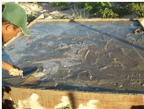
Img. 37 – Construção da base para apoio e nivelamento do reservatório na área 9. (Junho, 2012).
