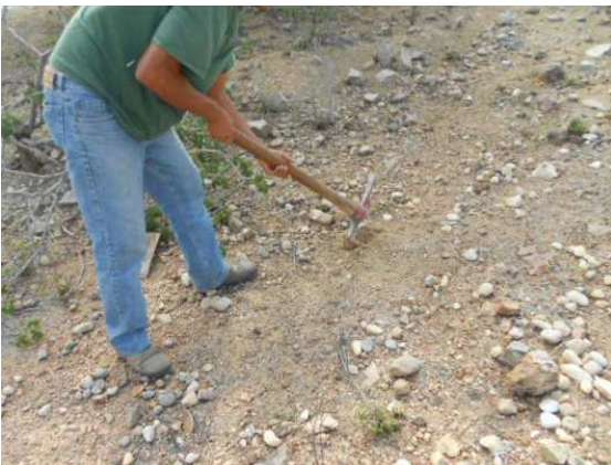
Img. 122 – Abertura manual das covas na área de jusante. (Abril, 2012).
