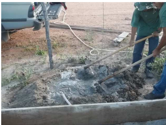
Img. 36 – Preparação de argamassa para construção da base para apoio do reservatório. (Junho, 2012).
