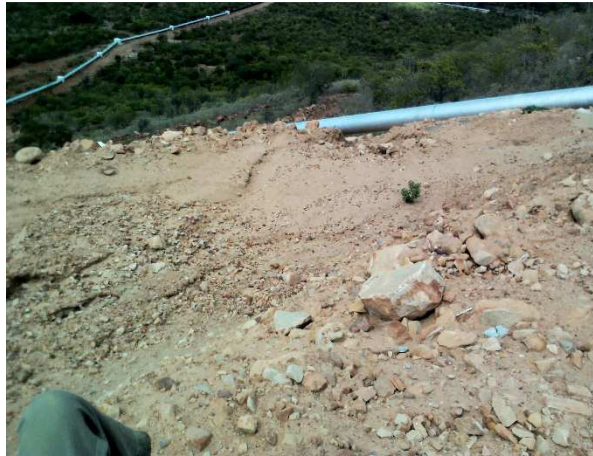
Img. 11 – Área de talude. (Abril, 2012).
