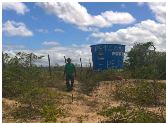
Img. 306– Reservatório ‘2’ da área 9. (Petcon 2014)
