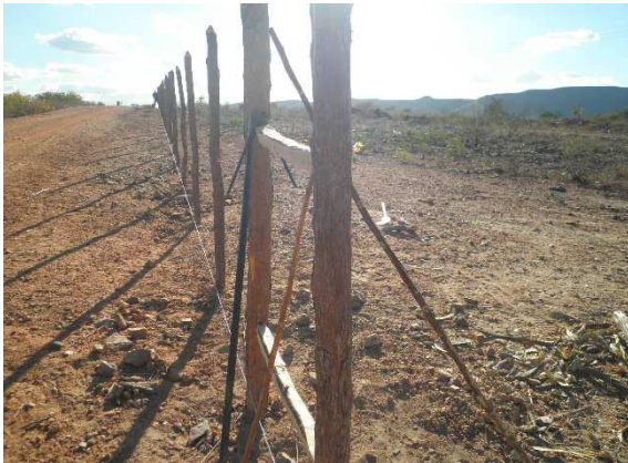
Img. 26 – Início do cercamento da área 10. (Maio, 2012)
