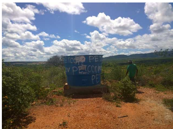
Img. 304 – Reservatório de água da área 7. (Petcon 2014)
