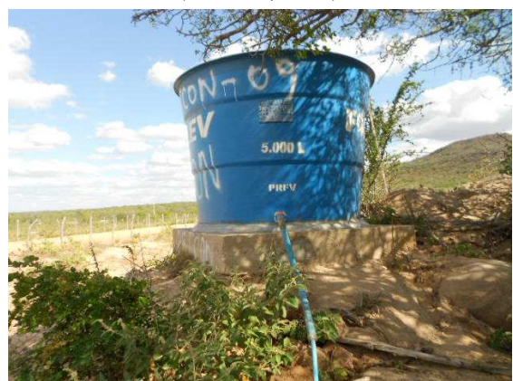
Img. 47 – Reservatório de fibra de vidro instalado na parte direita da área 09 (Janeiro, 2013)
