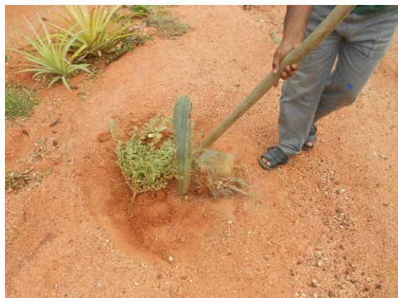
Img. 270 – Coroamento realizado área 05. (Petcon 2014)
