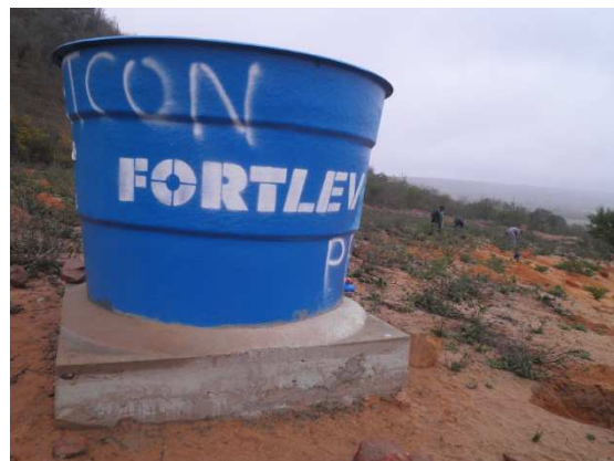
Img. 199 – Reservatório de fibra de vidro com capacidade para 5.000 litros Para irrigação das mudas plantadas. (Agosto, 2012).
