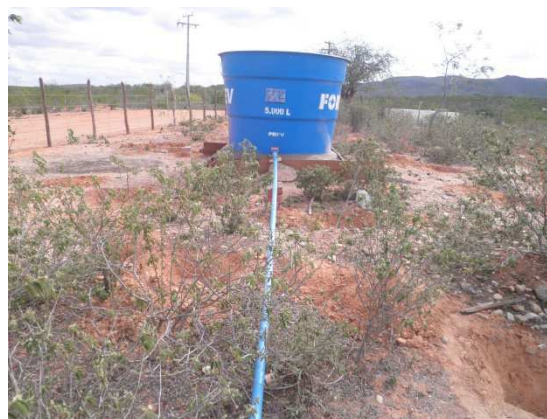
Img. 307 – Reservatório da área 10. (Petcon 2014)
