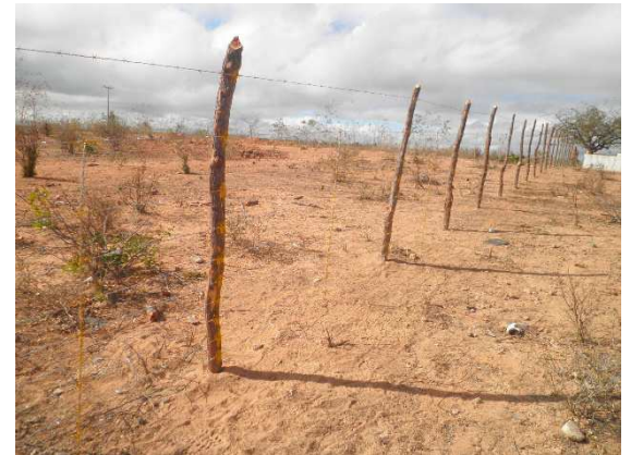
Img. 27 – Vista parcial da cerca concluída na área 10. (Maio, 2012)
