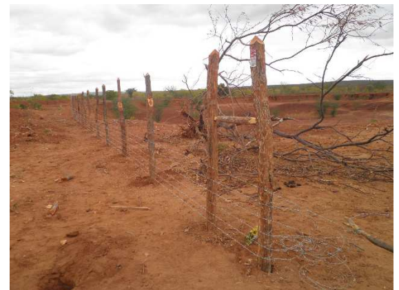
Img. 29 – Cercamento da área 3. (Maio, 2012)
