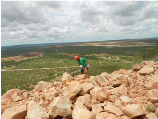
Img. 109 – Descida no talude com EPI's (Fevereiro 2014)
