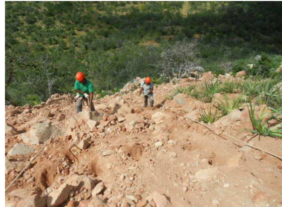
Img. 110 – Coveamento da área de talude (Fevereiro 2014)
