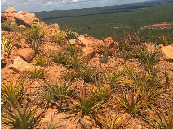
Img. 370 – Ótimo desenvolvimento das herbáceas plantadas no talude. (Petcon 2014)
