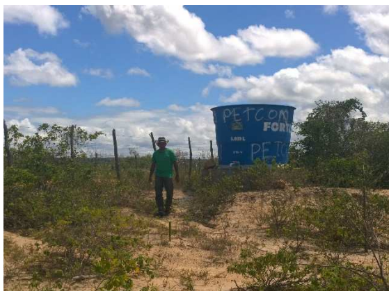
Img. 48 – Reservatório de fibra de vidro instalado do lado esquerdo da área 09 (Janeiro, 2013)
