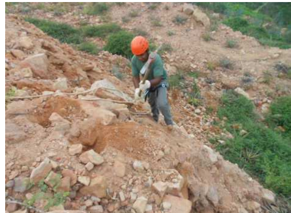
Img. 112 – Coveamento da área de talude (Fevereiro 2014)
