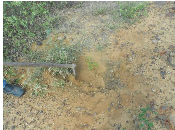
Img. 281 – Coroamento na jusante (Petcon 2014)
