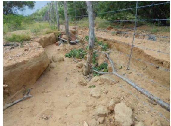
Img. 367 – A enxurrada provocada pela chuva provocou erosões, arrancou mudas e danificou a cerca da área 5. (Petcon 2014)
