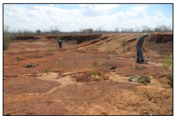
Foto 16 – Manutenção da área 3 (PETCON, 2013).
