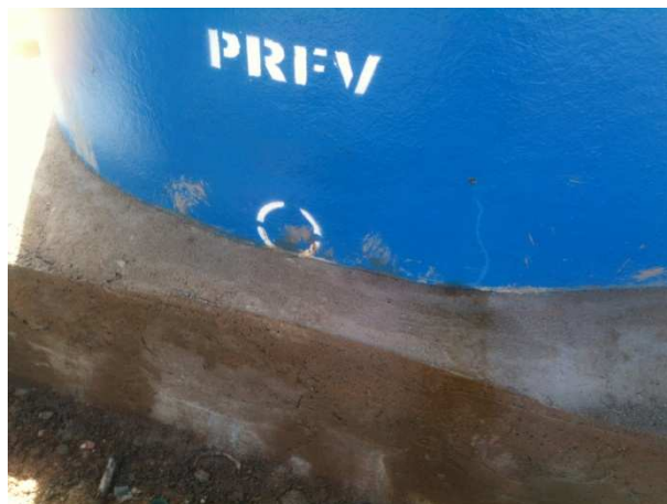
Foto 41 – Base de alvenaria para suporte da caixa. Silva, Elaine Cristina (Julho, 2012).
