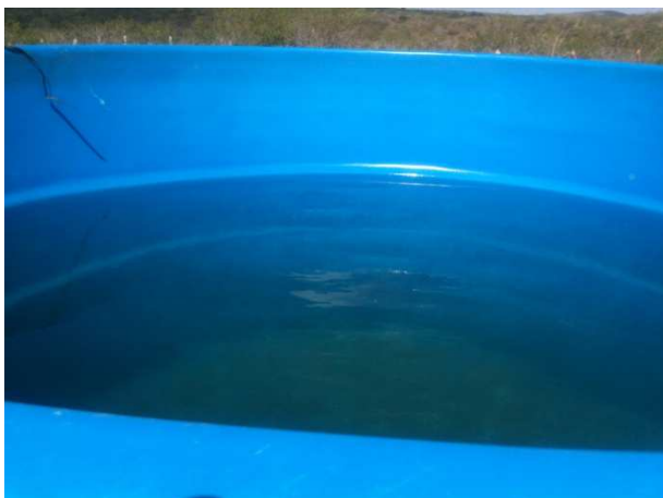
Foto 40 – Reservatório de água de fibra de vidro. Silva, Elaine Cristina (Julho, 2012).
