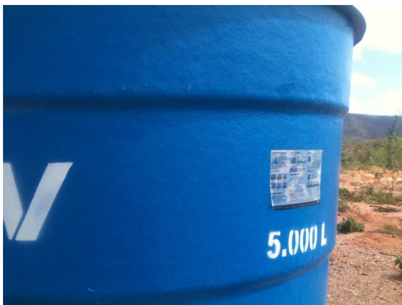
Foto 9 – Reservatório de fibra de vidro com capacidade para 5.000 litros. Silva, Elaine Cristina (Julho, 2012).
