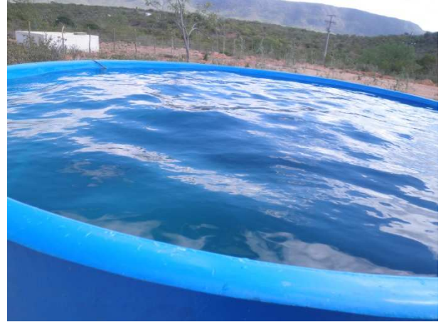
Foto 18 - Reservatório de fibra de vidro. Júnior, Guilherme (Junho, 2012).
