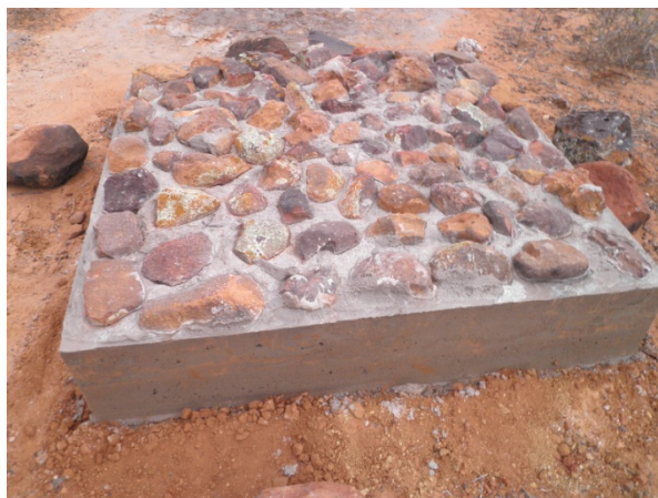
Foto 32 – Construção da base para apoio e nivelamento do reservatório. Silva, Elaine Cristina (Junho, 2012).
