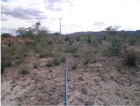
Foto 37 – Tubulação para irrigação. Silva, Elaine Cristina (Junho, 2012).
