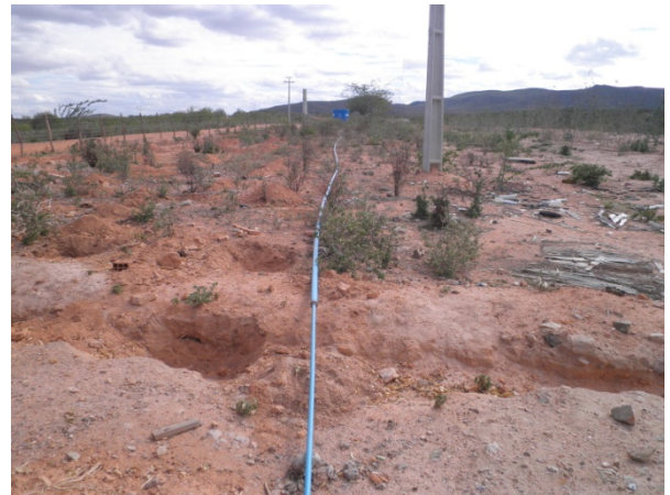
Foto 40 – Tubulação para irrigação. Silva, Elaine Cristina (Junho, 2012).
