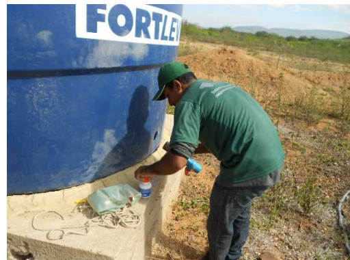
Fig. 37 – Instalação do sistema hidráulico.
