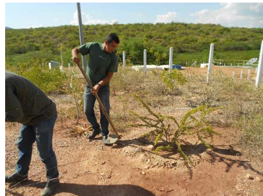
Fig. 23 – Coroamento na área 10.
