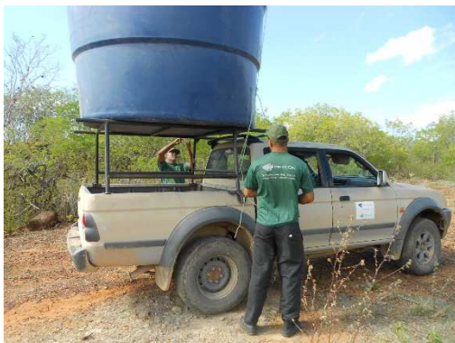
Fig. 36 – Substituição da caixa d'água danificada.
