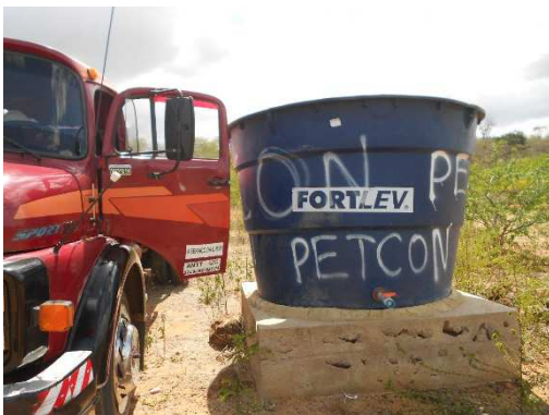
Fig. 10 – Nova caixa d'água instalada sendo abastecida na área 04.
