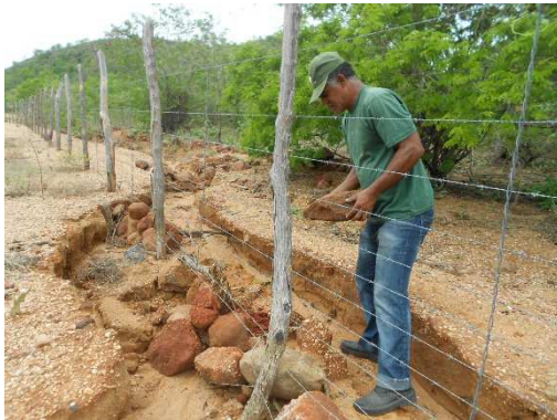
Fig. 42 – Contenção da erosão com pedras na área 5.
