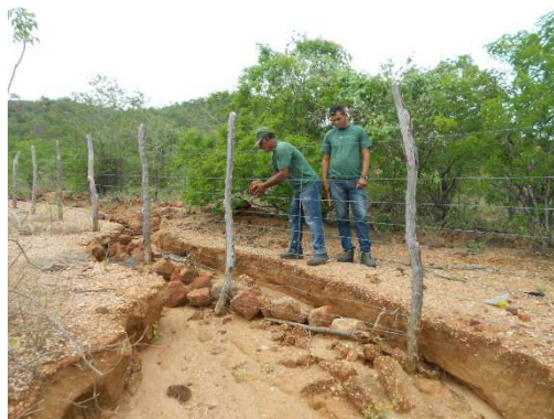
Fig. 25 – Contenção de processo erosivo provocado pela chuva e manutenção da cerca na área 5
