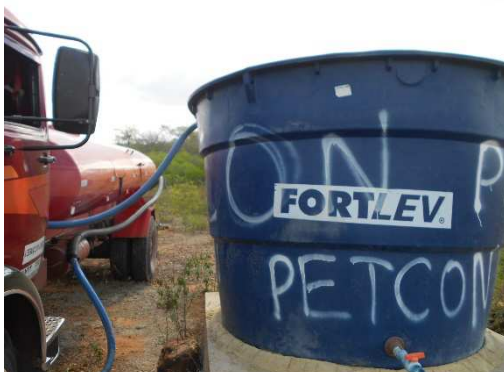
Fig. 38 – Abastecimento da caixa d'água recém instalada.
