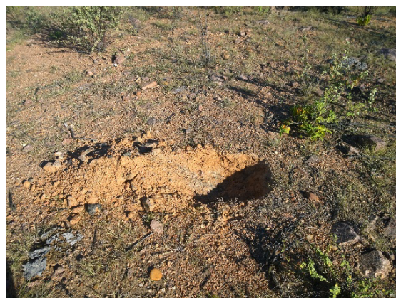
Fig. 23 – Coveamento na área de Jusante (Petcon 2014)
