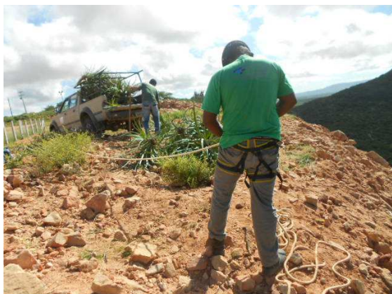
Fig. 24 – Devido a inclinação o plantio no Talude exige a utilização de EPI's especiais (Petcon 2014)
