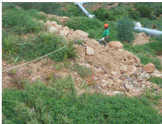
Fig. 25 – Equipamentos para Rapel é utilizado no Talude (Petcon 2014)
