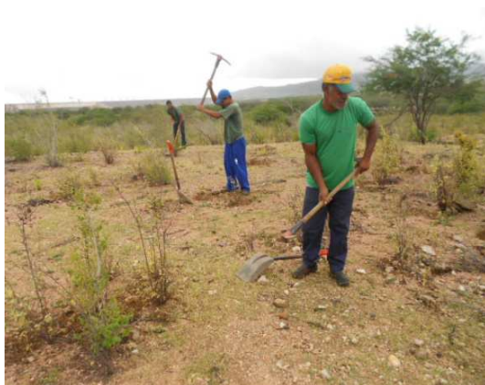
Fig. 18 – Aberturas de covas na área de Jusante (Petcon 2014)
