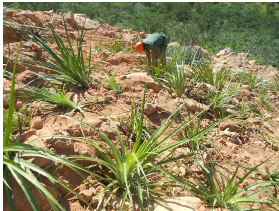
Fig. 32 – Plantio de Macambira no Talude (Petcon 2014)
