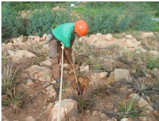
Fig. 34 – Abertura de covas para o plantio no Talude (Petcon 2014)
