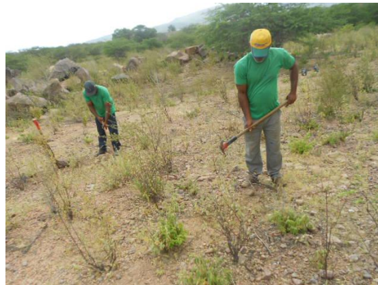
Fig. 29 – Coveamento próximo a ponte do rio na área de Jusante (Petcon 2014)
