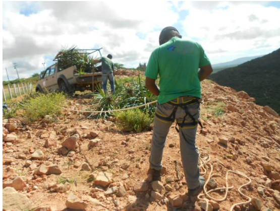
Fig. 30 – Devido a inclinação o plantio no Talude exige a utilização de EPI's especiais (Petcon 2014)
