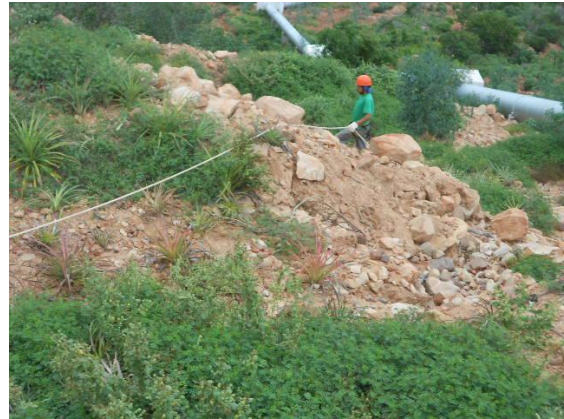
Fig. 31 – Equipamentos para Rapel é utilizado no Talude (Petcon 2014)
