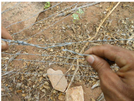
Fig. 24 – Cerca danificada por ferramenta manual na área 04 (Petcon 2014)
