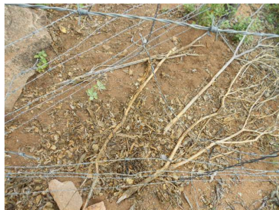
Fig. 25 – Manutenção da cerca danificada na área 04 (Petcon 2014)
