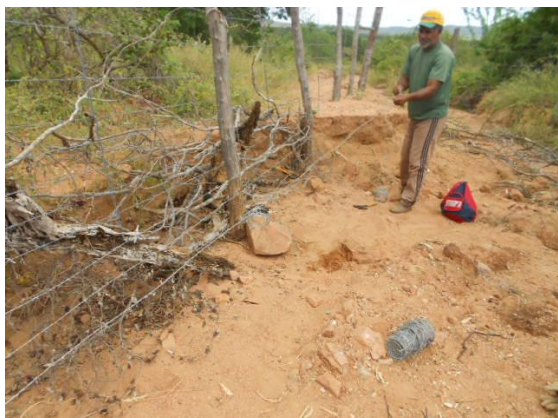
Fig. 22 – Manutenção da cerca na área 05 (Petcon 2014)
