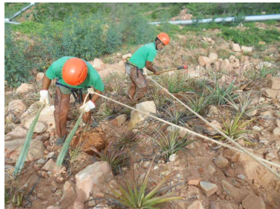
Fig. 35 – Plantio de Mandacaru no Talude (Petcon 2014)
