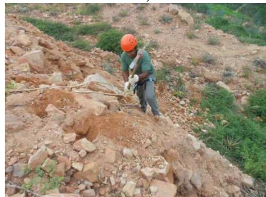
**Figura 14 – Coveamento da área de talude (Petcon 2014)**
