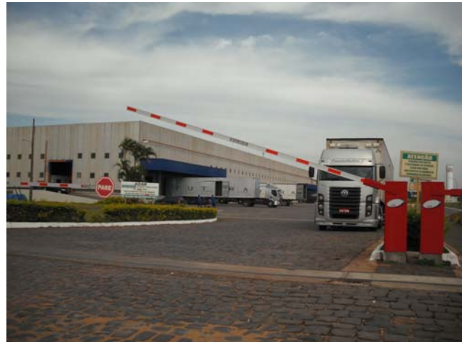
FIGURA 59 – Vista de uma área industrial, em Três Lagoas – MS.
