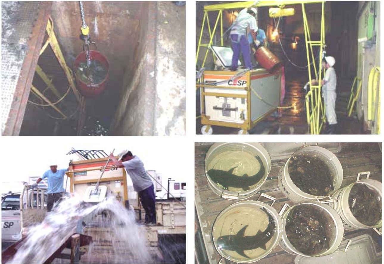
FIGURA 10 – Salvamento de peixes na caixa espiral e tubo de sucção da UHE Eng. Souza Dias (Jupiá)
