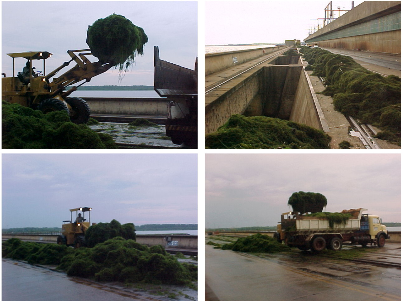
FIGURA 04 – Coleta de detritos da tomada d'água da UHE Eng. Souza Dias (Jupiá)
