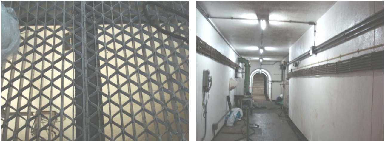
FIGURA 09 – Galeria do poço de drenagem na UHE Eng. Souza Dias (Jupiá)
