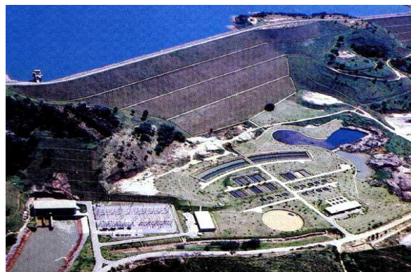
Figura 6. Vista da UHE Paraibuna.
