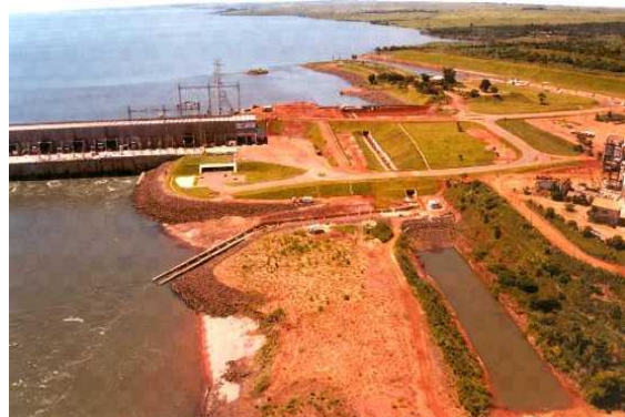
Figura 10. Vista geral da escada para peixes da UHE Engenheiro Sérgio Motta (Porto Primavera).
