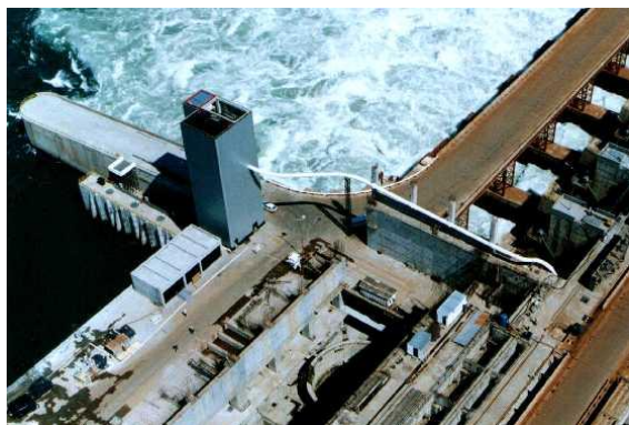
Figura 9. Vista geral do elevador para peixes da UHE Engenheiro Sérgio Motta (Porto Primavera).
