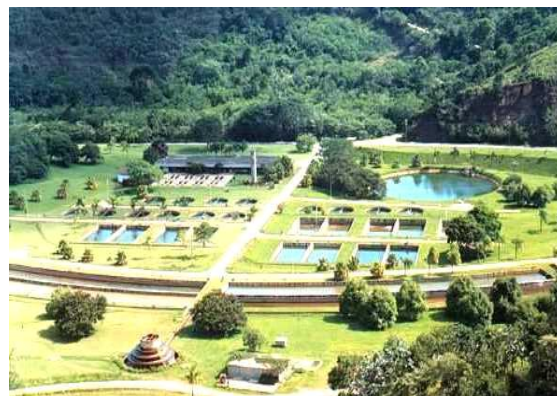
Figura 8. Vista geral da Estação de Hidrobiologia e Aquicultura de Paraibuna.
