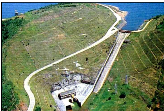
Figura 5. Vista da UHE Jaguari.
