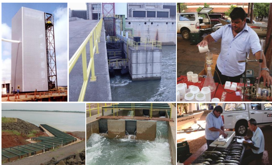
Elevador, escada de peixes, levantamentos limnológicos e ictiológicos no reservatório da UHE Engenheiro Sérgio Motta (Porto Primavera).
