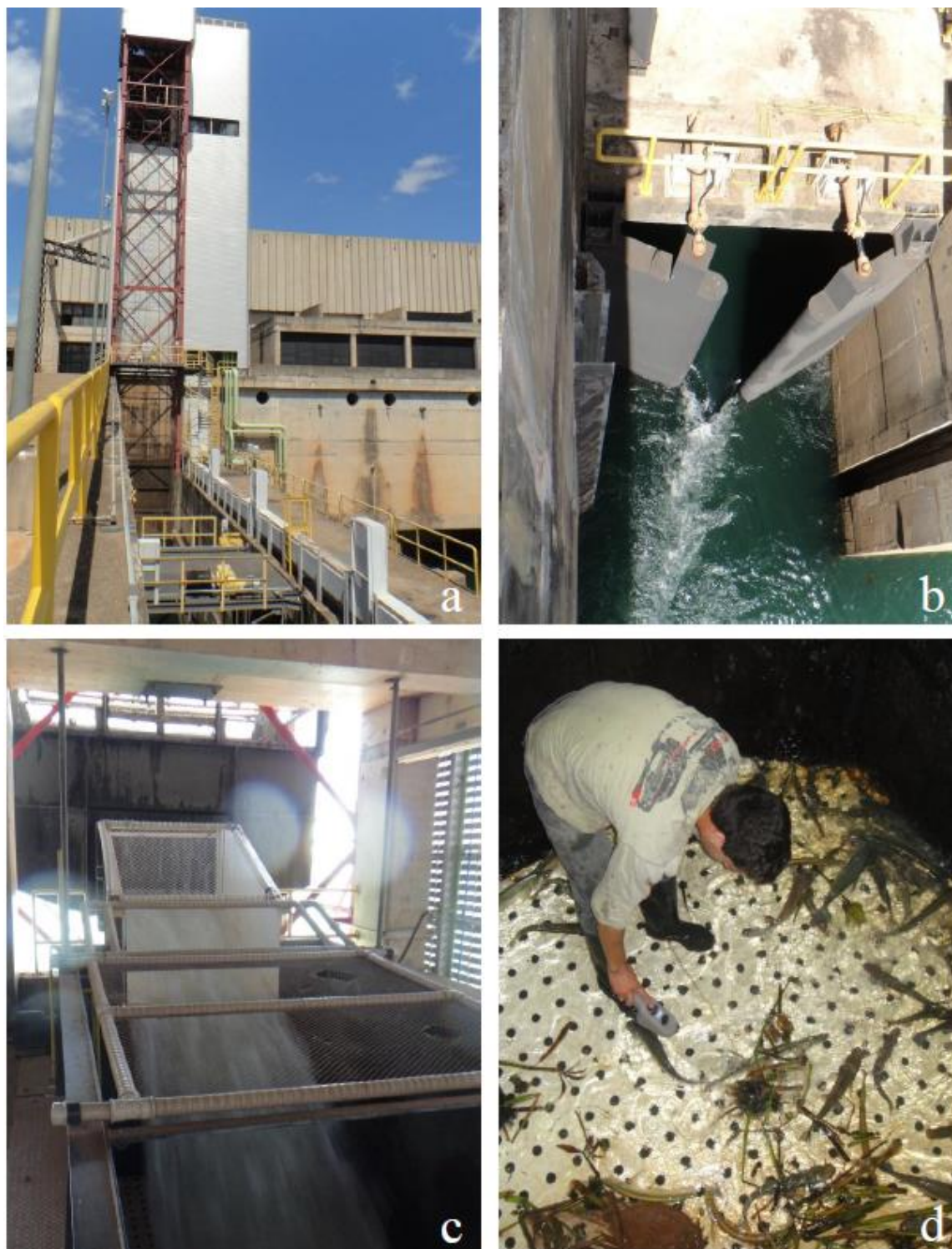
Figura 5 – Visão geral do elevador para peixes (a). Fluxo de atração gerado pelas bombas elétricas, passando pelas comportas mitrais (b). Caçamba do elevador para peixes içada, liberando o conteúdo dentro do tanque-balança (c). Procedimento de scanner manual dos peixes transpostos pelo elevador.
