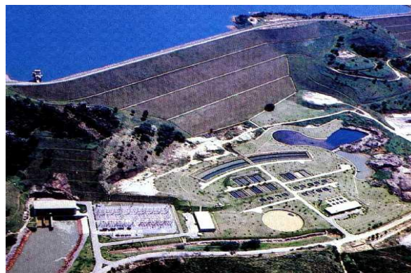
Figura 7. Vista da UHE Paraibuna.
