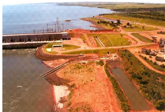
Figura 11. Vista geral da escada para peixes da UHE Engenheiro Sérgio Motta (Porto Primavera).
