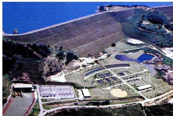
Figura 7. Vista da UHE Paraibuna.
