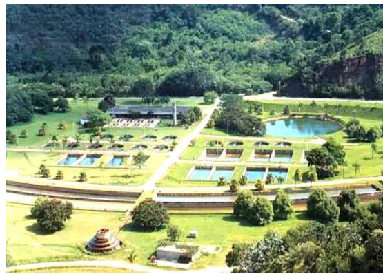
Figura 9. Vista geral da Estação de Hidrobiologia e Aquicultura de Paraibuna.
