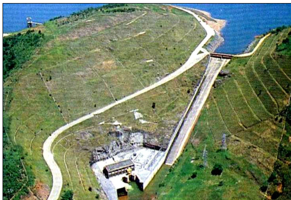
Figura 6. Vista da UHE Jaguari.
