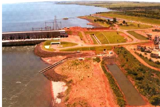
Figura 11. Vista geral da escada para peixes da UHE Engenheiro Sergio Motta.
