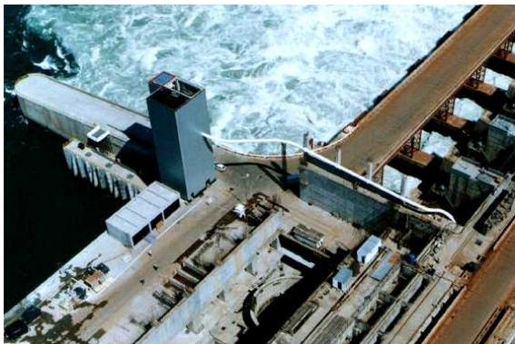
**Figura 10.** Vista geral do elevador para peixes da UHE Engenheiro Sérgio Motta.
