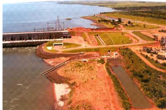
**Figura 11.** Vista geral da escada para peixes da UHE Engenheiro Sérgio Motta.
