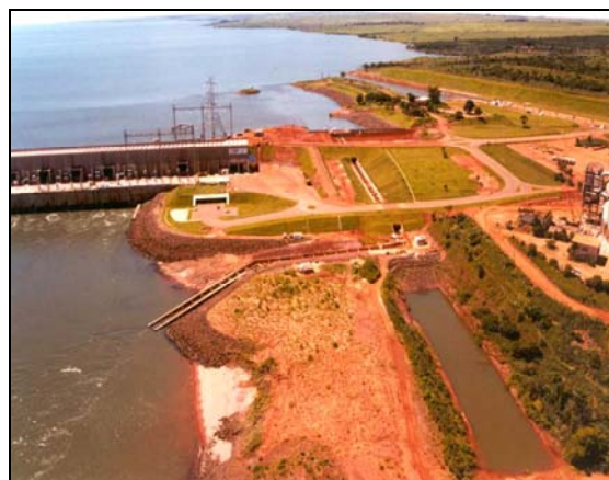
Figura 11. Vista geral da escada para peixes da UHE Engenheiro Sergio Motta.
