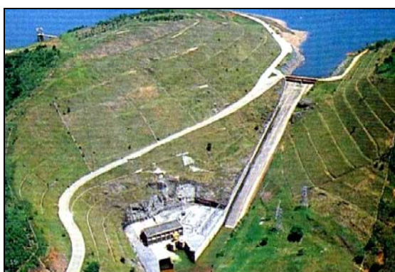
Figura 6. Vista da UHE Jaguari.
