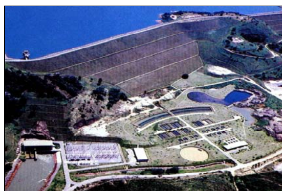
Figura 6. Vista da UHE Paraibuna.
