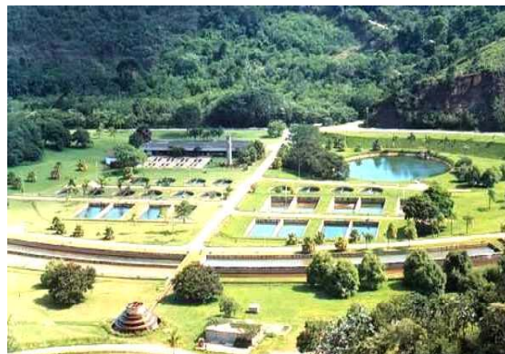
Figura 9. Vista geral da Estação de Hidrobiologia e Aqüicultura de Paraibuna.
