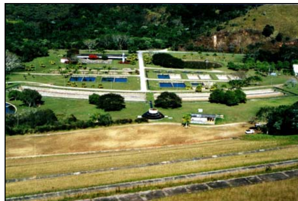
Figura 9. Vista geral da Estação de Hidrobiologia e Aqüicultura de Paraibuna.
