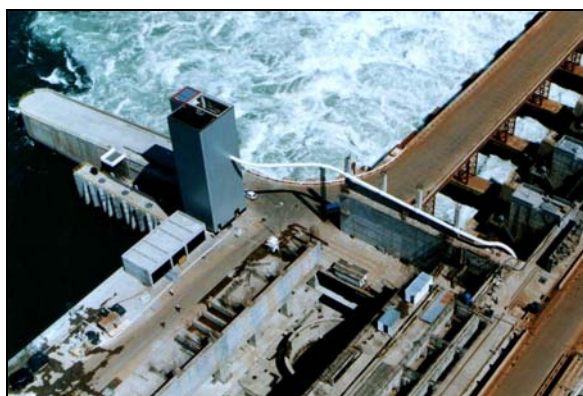
Figura 10. Vista geral do elevador para peixes da UHE Engenheiro Sérgio Motta (Porto Primavera).
