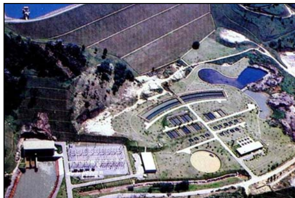
Figura 7. Vista geral da UHE Paraibuna.
