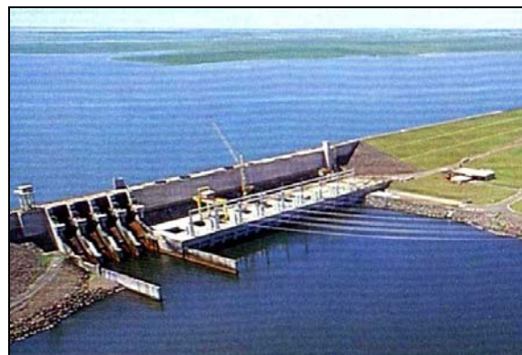
Figura 3. Vista geral da UHE Ilha Solteira.
