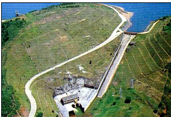
Figura 6. Vista geral da UHE Jaguari.
