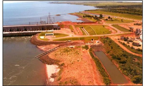
**Figura 11.** Vista geral da escada para peixes da UHE Engenheiro Sérgio Motta (Porto Primavera).
