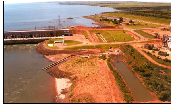
Figura 11. Vista geral da escada para peixes da UHE Engenheiro Sérgio Motta.
