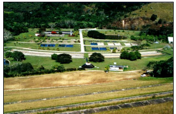
Figura 9. Vista geral da Estação de Hidrobiologia e Aquicultura de Paraibuna.
