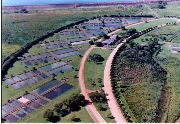
Figura 8. Vista geral da Estação de Hidrobiologia e Aquicultura de Jupia.
