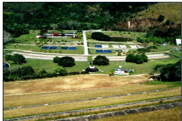
Figura 11. Vista geral da Estação de Hidrobiologia e Aquicultura de Paraibuna.
