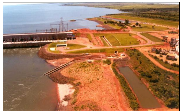
Figura 13. Vista geral da escada para peixes da UHE Engenheiro Sérgio Motta.
