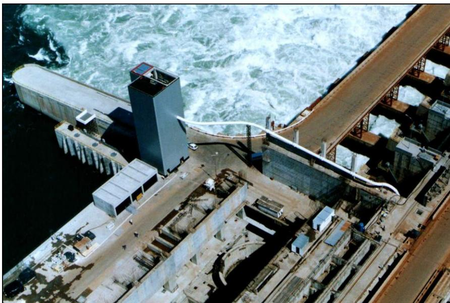
**Figura 09.** Elevador para peixes da UHE Engenheiro Sérgio Motta
