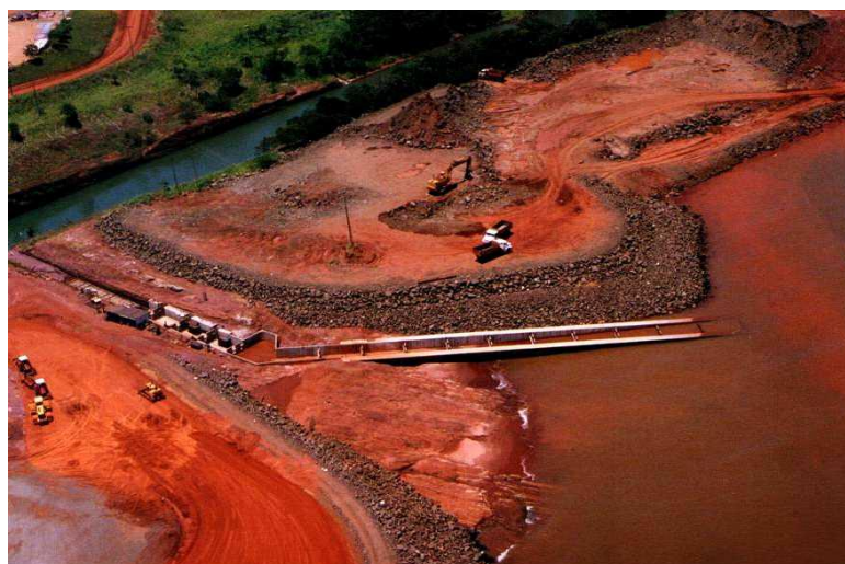
Foto 09. Obras da escada para peixes da UHE Eng o Sérgio Motta
