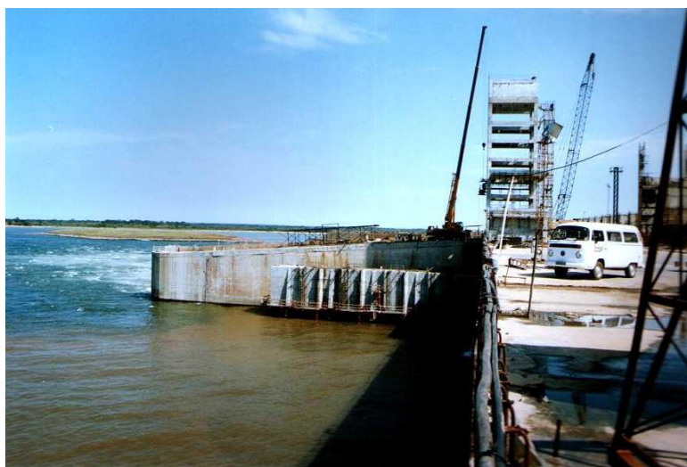
Foto 08. Obras do elevador para peixes da UHE Eng o Sérgio Motta
