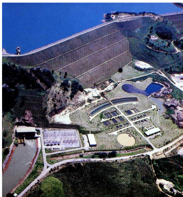
Foto 06. Vista da UHE Paraibuna, apresentando também a Estação de Hidrobiologia e Aquicultura
