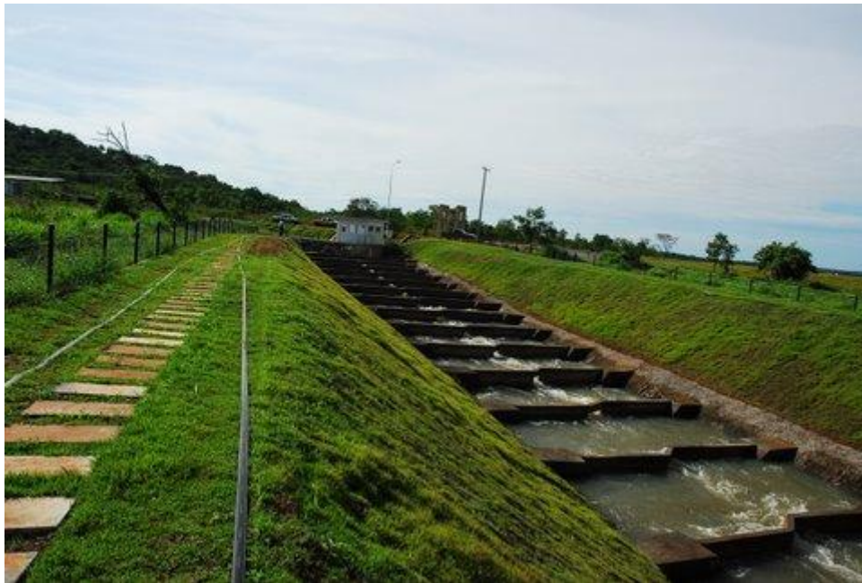
Figura 1. Escada de Peixes da PCH Paranatinga II – Seção Trapezoidal com largura de base de 2,0 m.
