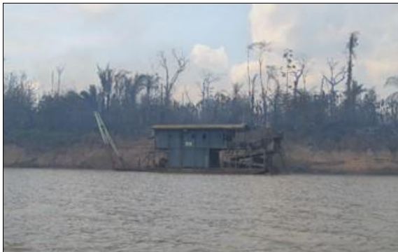
Figura 17 - Erosão do talude devido à ação antrópica (atividade garimpeira) na margem direita do rio Madeira a montante, no ponto MMD-28.
